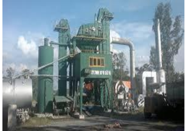
Trạm bê tông nhựa
